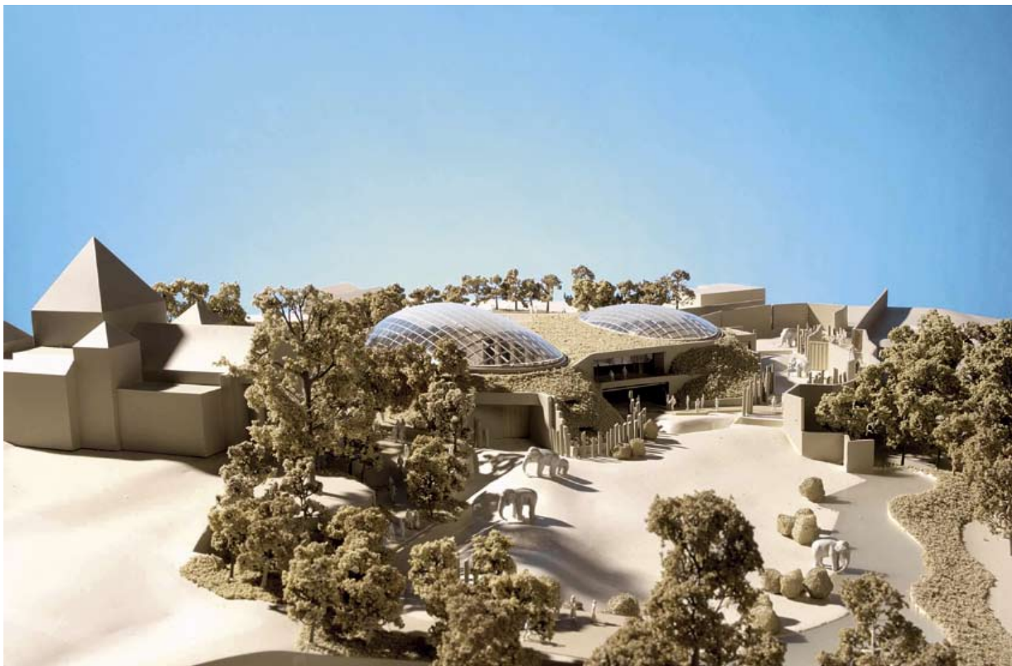
Elefanthusets komplekse kuppeltage i stål og glas er projekteret i Wien og produceres i Tjekkiet. De øverste glas er coated med 60 pct. silketryk som gradueres nedefter til 15 pct. for at dæmpe den høje middagssol og alligevel slippe masser af dagslys ind.
